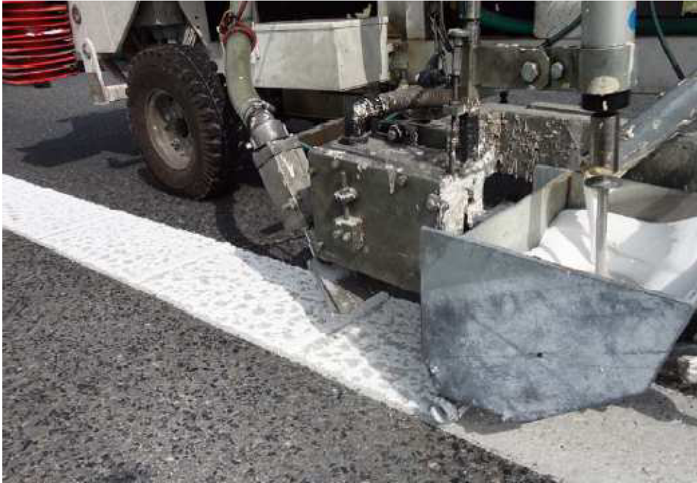
Obrázek 22: Pokládka vodorovného dopravního značení [24]
