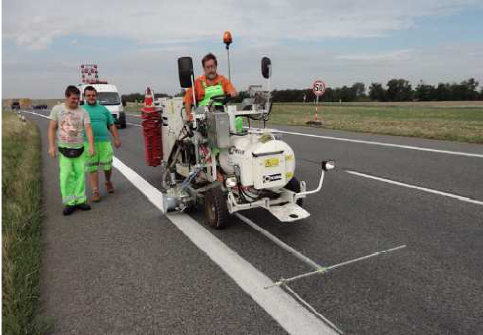
Obrázek 20: Pokládka vodorovného dopravního značení [24]
