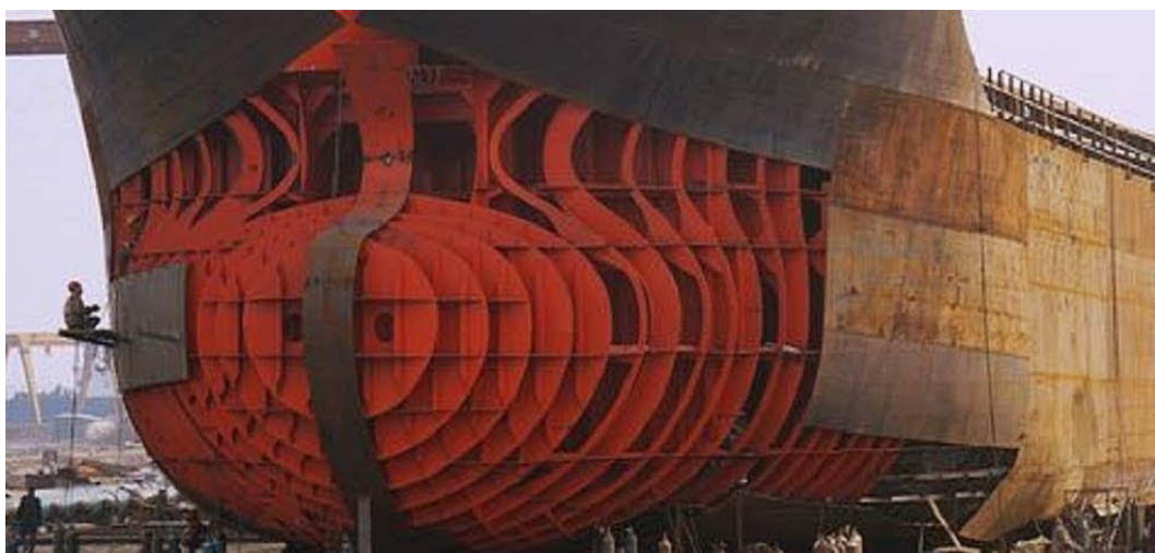
Obr. 2-26 Přivařování ocelových plechů na nosnou konstrukci trupu [46]
