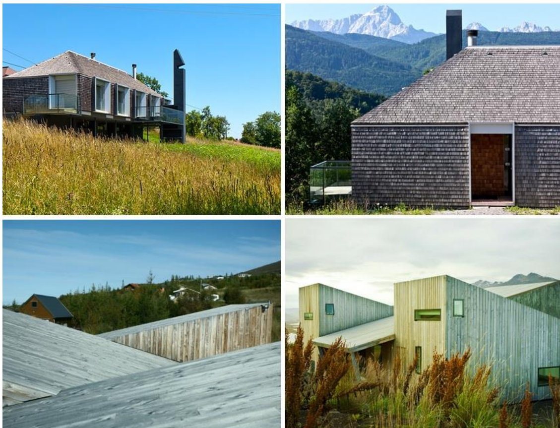
Obr. 46: Dřevěné střešní krytiny 30
