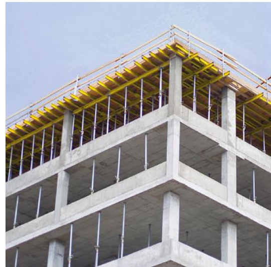
Obr. 69 – Zábradlí systémového bednění
