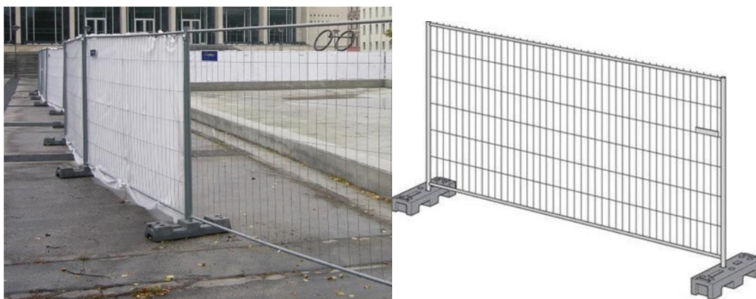
Obr. 19 – Dílcové oplocení, značky umístěné na oplocení
