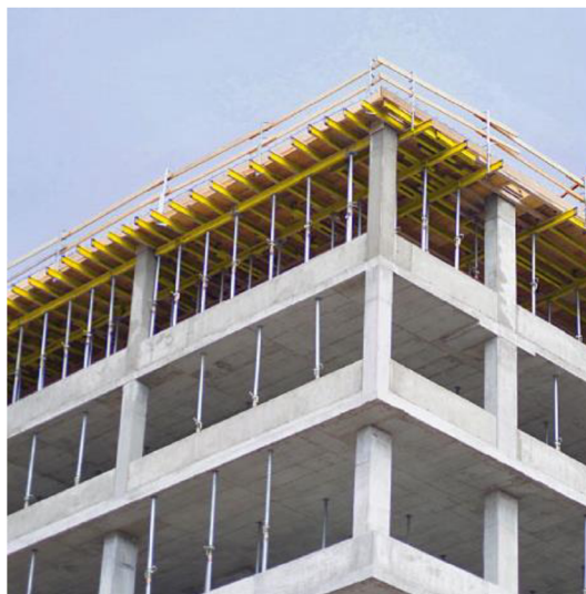
Obr. 69 – Zábradlí systémového bednění
