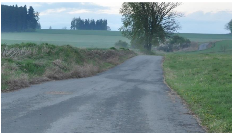
Foto 2: HPC 2, rekonstruovaná hlavní polní cesta, autor: Jana Kofanova, 2014.
