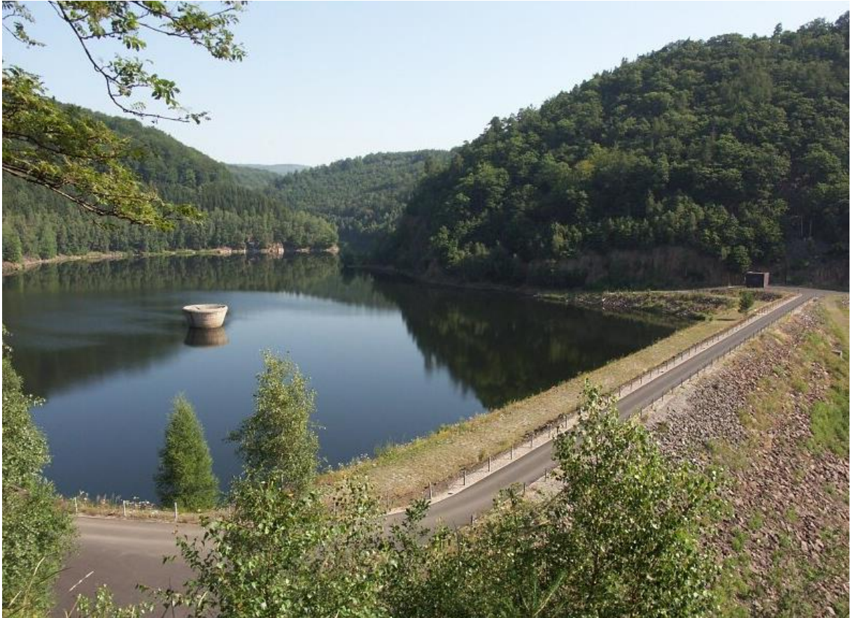
Obr. 2.3 Pohled na VD Jirkov s šachtovým přelivem [12]
