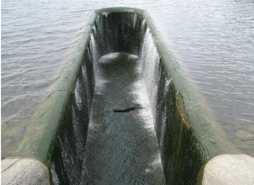
Obr. 2.5 Přeliv typu kachní zobák, VD Pilská [13]
