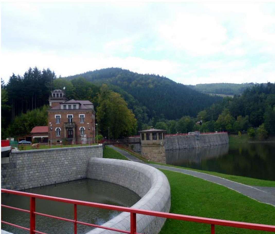
Obr. 2.6 Přeliv půdorysně zakřivený nízký na VD Bystřička [13]
