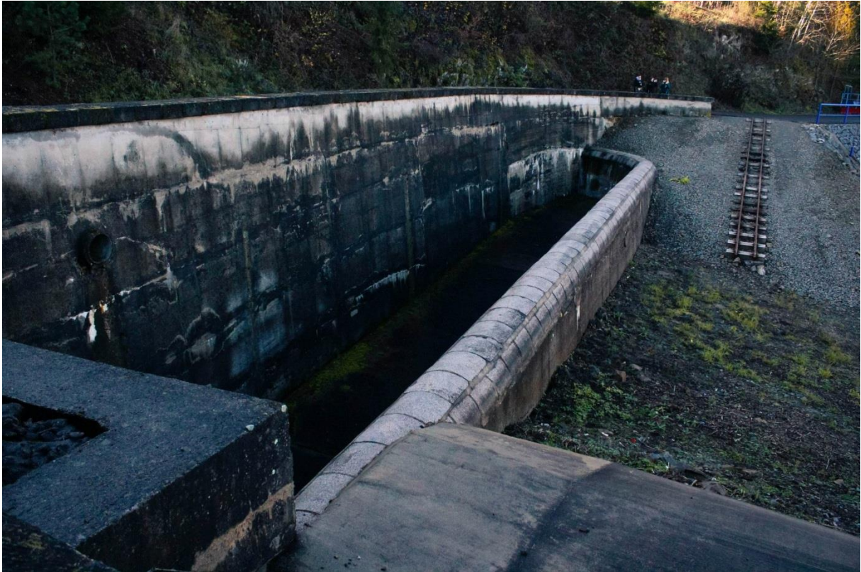
Obr. 2.7 Přeliv složený, VD Opatovice [14]
