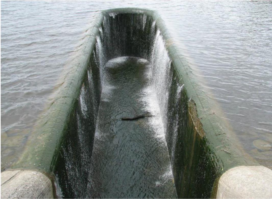
Obr. 2.5 Přeliv typu kachní zobák, VD Pílská [13]
