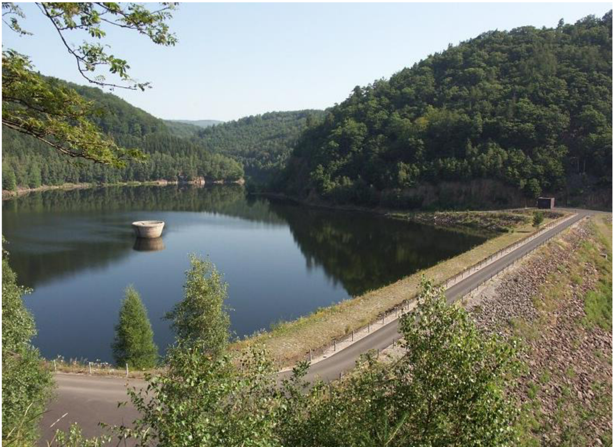
Obr. 2.3 Pohled na VD Jirkov s šachtovým přelivem [12]
