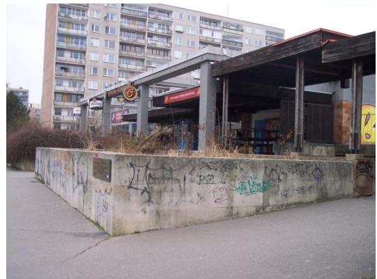
Obr. č. 14: Vstup do restaurace
