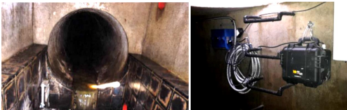
Obr. 4.20 Měrný profil Q2 (vlevo) a datalogger ISCO 2150 (vpravo)
