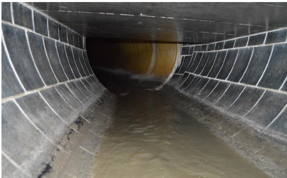
Obr. 4.14 Detail profilu potrubí v odlehčovací komoře [34]
