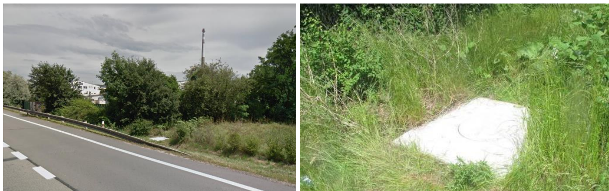
Obr. 4.5 Vstupní šachta do OK Karásek – Loučky [33]
