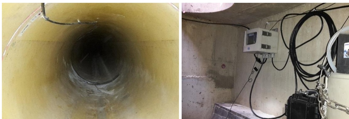
Obr. 4.29 Měrný profil H3 a datalogger ISCO Signature
