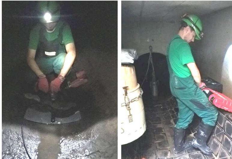
Obr. 4.2 Instalace měřící techniky
