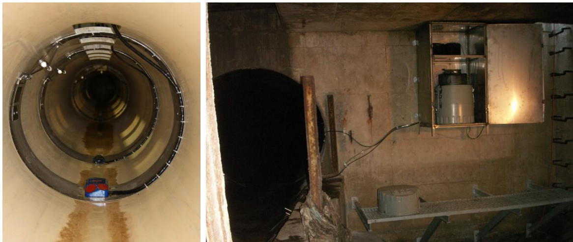
Obr. 3.1 Monitoring stokových sítí [16]
