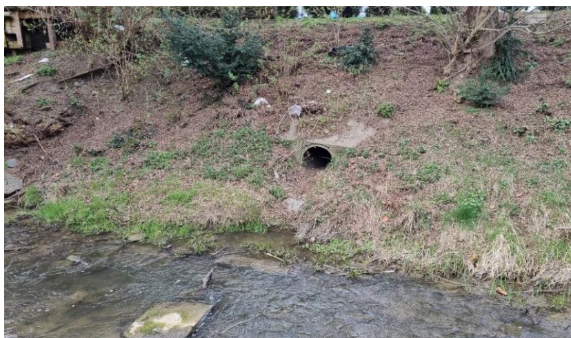
Obr. 21 Vyústění kanalizace pod ulicí Sídliště Zahradní [39]
