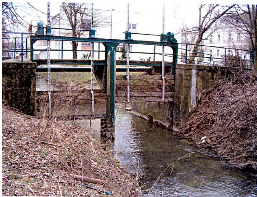
Obr. 20 Původní jezový objektu ze strany nátoky [19]
