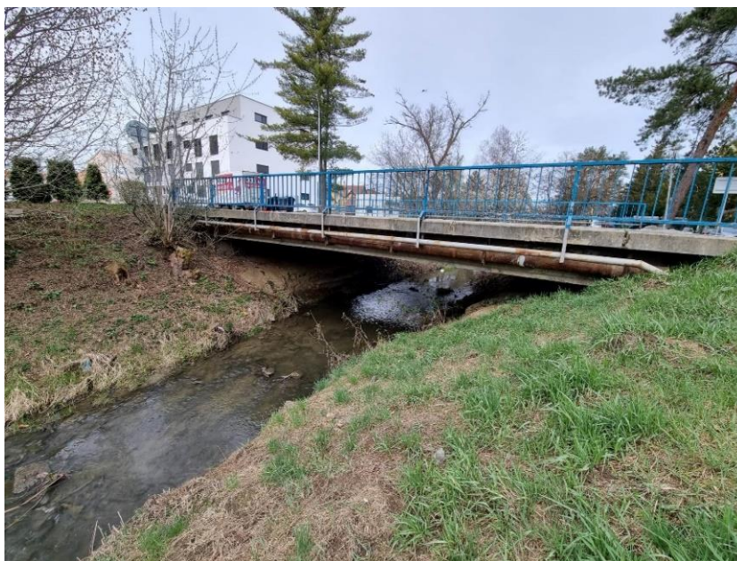
Obr. 22 Cestní most M58 ze strany výtoku [39]
