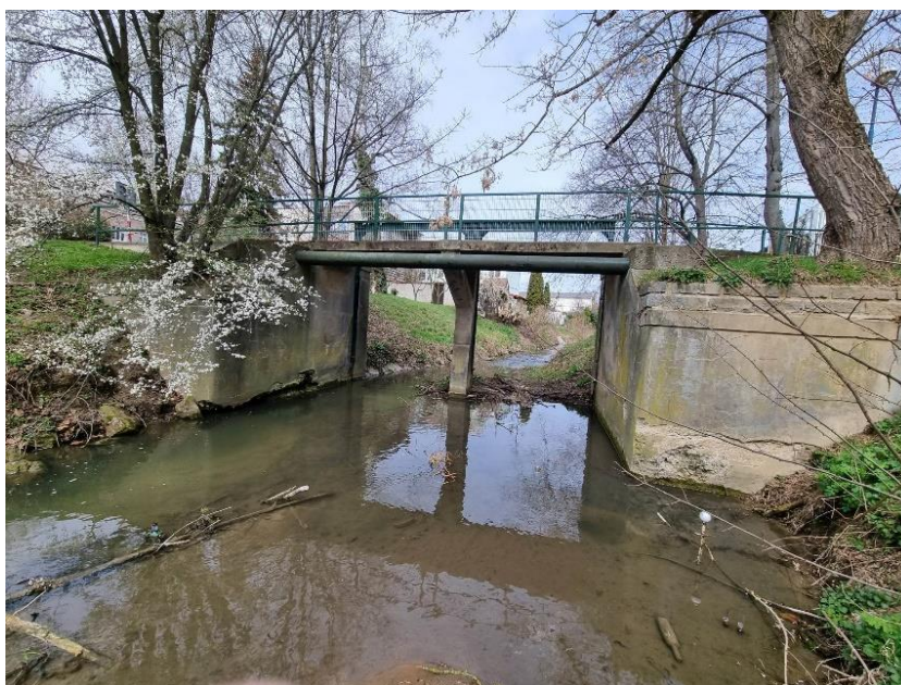
Obr. 23 Lávka pro pěší M57 a ze strany výtoku [39]
