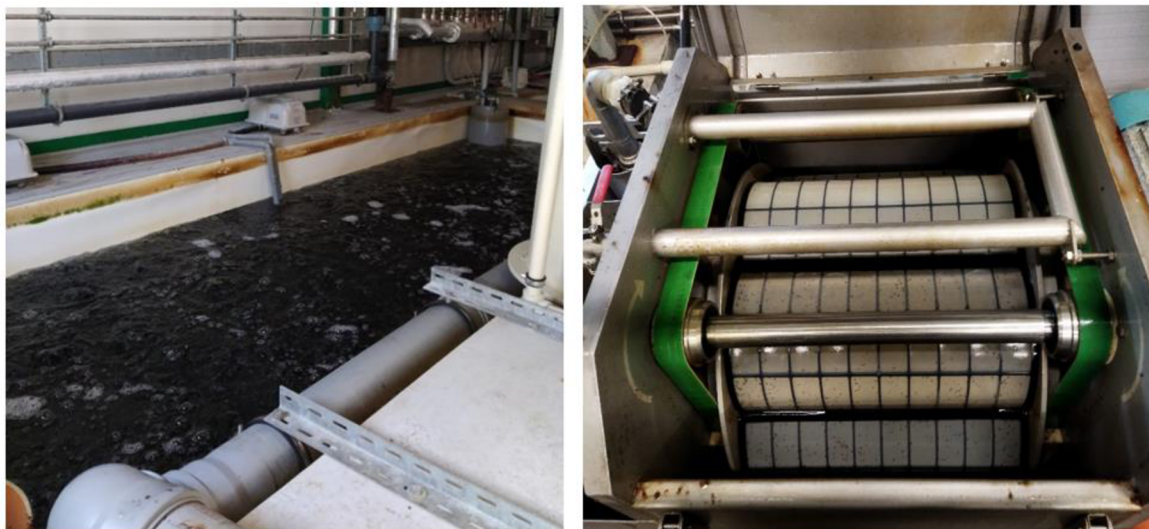
Obrázek č. 9 a 10: Vlevo: Biologický filtr s pohyblivým ložem naplněný biologickými medii (foto: V. Kučera) vpravo: Mechanický bubnový filtr (foto: V. Kučera)
