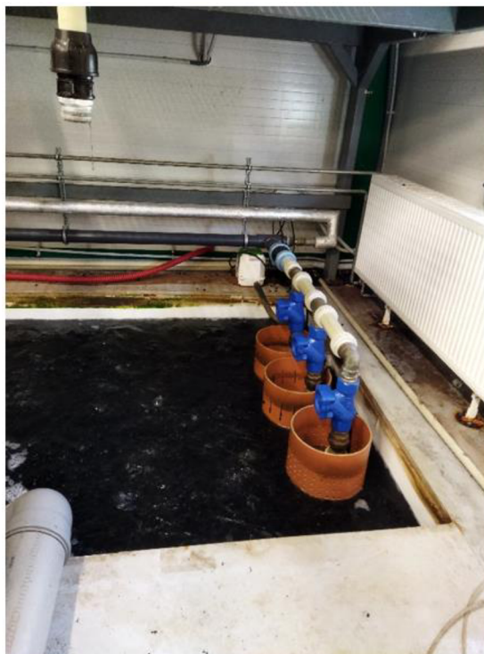
Obrázek č. 7 a 8: Vlevo: Nádrže a kontrola stavu obsádky (foto: P. Dobrovolný), Vpravo: Biologický filtr s pohyblivým ložem s trojicí ponořených kalových čerpadel (foto: V. Kučera)
