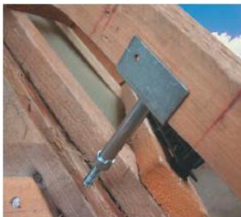
Obr. č. 24 - Osazení hřebenové latě
