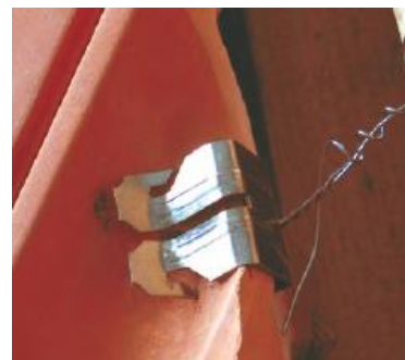
Obr. č. 28 - Přichycení řezaných tašek
