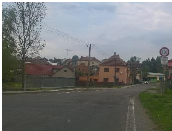
Obr. č. 2 - Zájmový bod 1a - Most v Ostrově nad Oslavou
