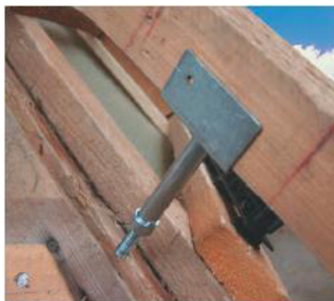
Obr. č. 24 - Osazení hřebenové latě
