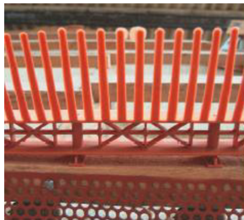
Obr. č. 25 - Ochranná větrací mřížka a ochranný větrací pás okapní
