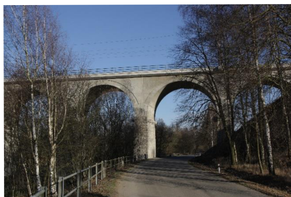
Obr. č. 4 - Zájmový bod - 2 - Viadukt za Ostrovem nad Oslavou
