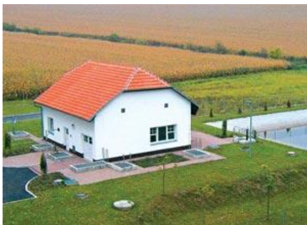
Obrázek 3 Čistírna odpadních vod
