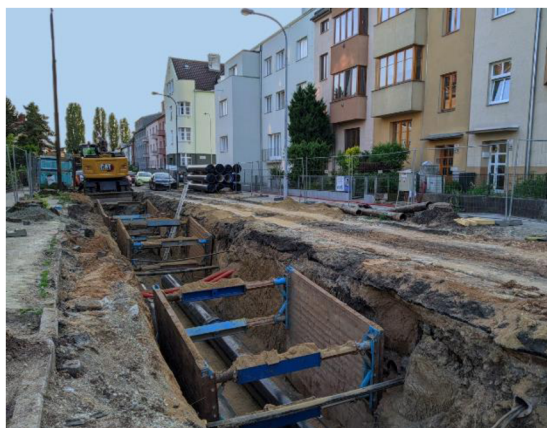
Fotografie 2: Oprava vodovodu na ulici Krkoškova, (zdroj: archiv autorky)
