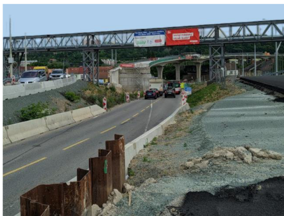
Fotografie 1: Stavba velkého městského okruhu na Tomkově náměstí, Brno (zdroj: archiv autorky)
