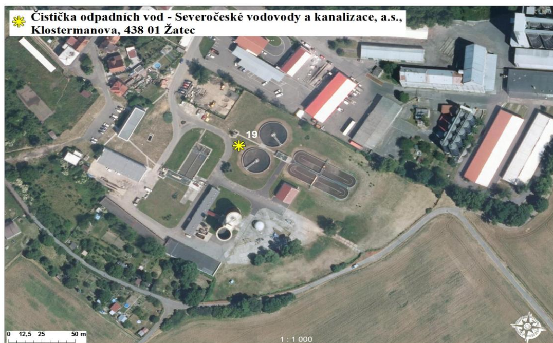
Obr. č. 20: Severočeské vodovody a kan.- ČOV
