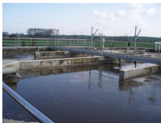
Obr. 4 – Čistička odpadních vod
