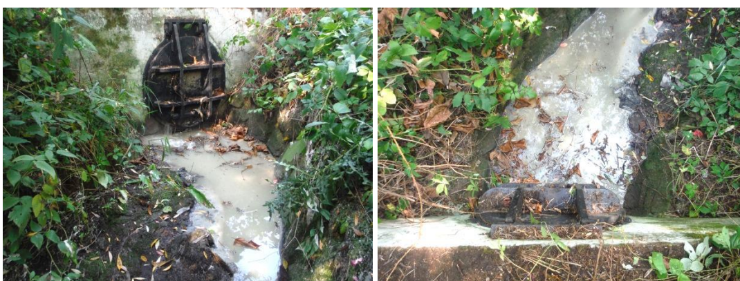
Obrázek 5 a 6: Výústní objekt OK v Tábořské ulici - lidová škola umění, profil betonové trouby DN 800 s žabí klapkou, při činnosti odlehčení (ze dne 19. 9. 2018).
