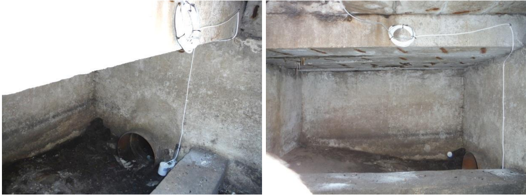
Obrázek 29 a 30: Ukázka vedení kabelu vodiče mezi vysílačem a čidlem zaplavení v OK č. 23, Dalovice, Hlavní ul. x Všeborovická ul., u masny.
