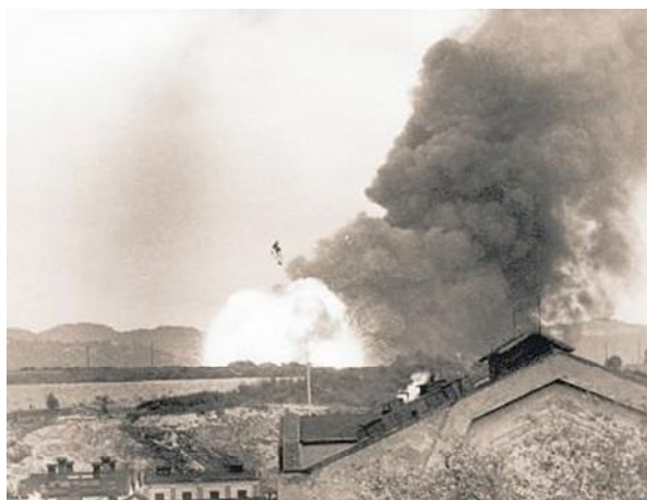
Pohled na výbuchy z oken Schichtových závodů
