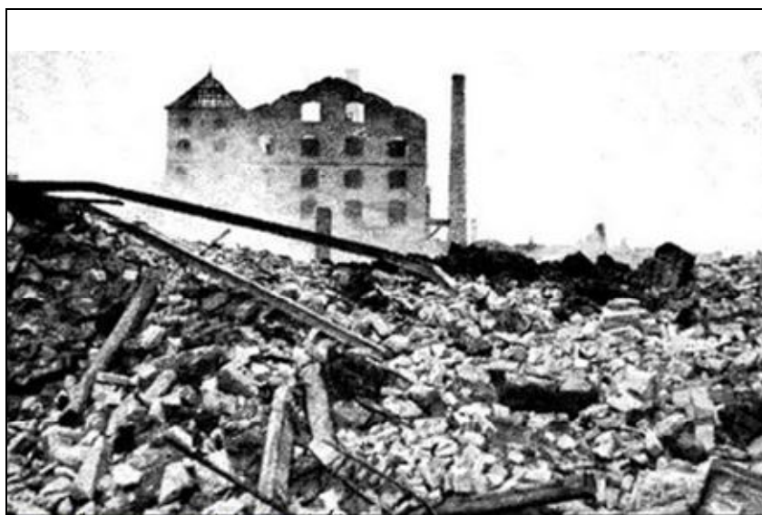
Demolovný muniční sklad
