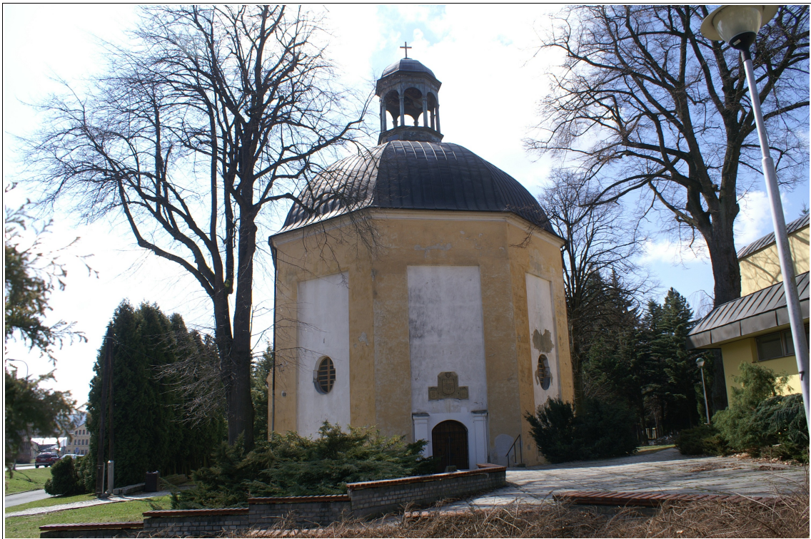
Hřbitovní kaple sv. Michala v Bruntále
