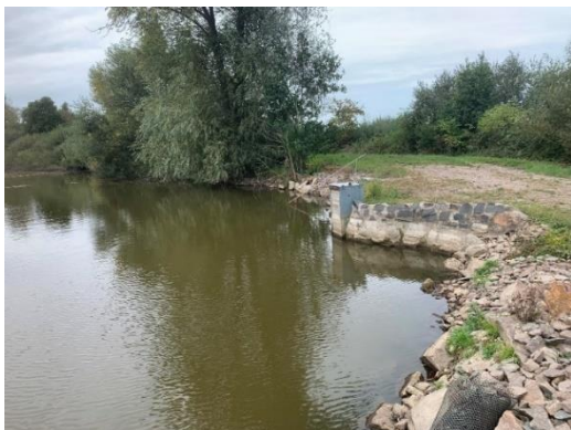
Obr. 99: 17.2. Zmotálek, část hráze (fotografie Patrik Křížek)
