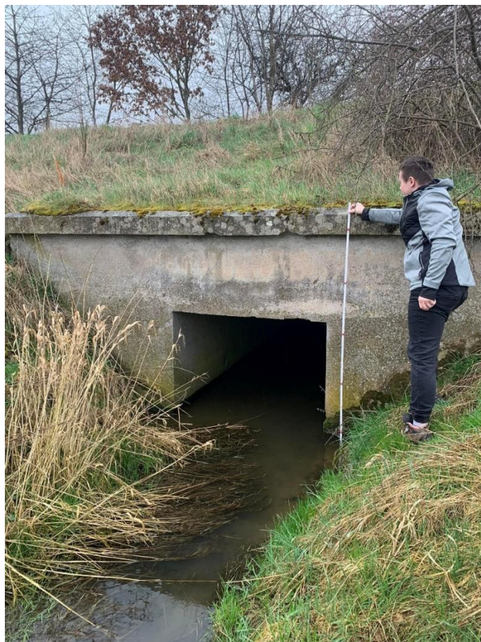
Obr. 7: 1.1. Bezejmenné vodní dílo, betonová propust (fotografie Mgr. Nikola Křížková).
