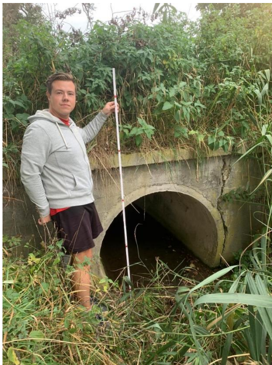
Obr. 89: 15.3. Bezejmenné vodní dílo, propust (fotografie Patrik Křížek)
