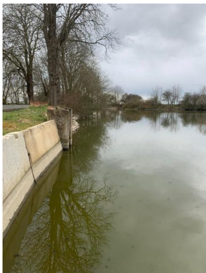
Obr. 14: 2.1. Vazový rybník, část hráze s výpustí (fotografie Patrik Křížek)
