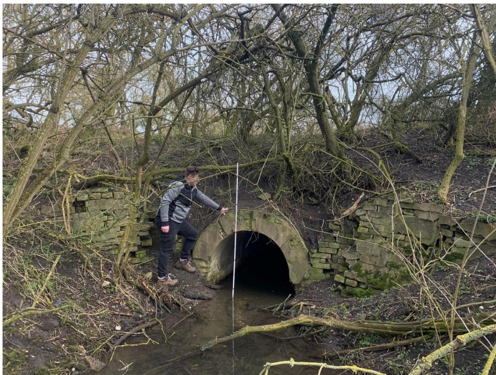
Obr. 37: 6.1. Čírek, propust a část hráze (fotografie Mgr. Nikola Křížková)
