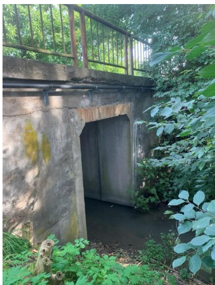
Obr. 31: 5.1. Výklekový rybník, propust (fotografie Patrik Křížek)
