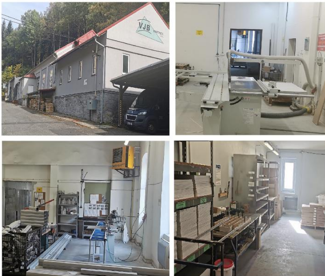
Obrázek 10: Stav po rekonstrukci a instalaci technologií
