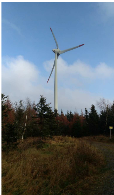
Obr. č. 3 Větrná elektrárna Klíny – Mračný vrch
