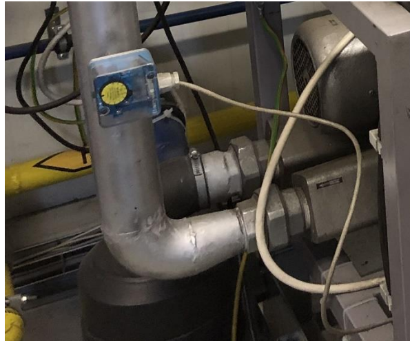
Obr. 5.6 Realizace zúžení vstupního a výstupního potrubí dmyhadla vzduchu SAP300 [10]
