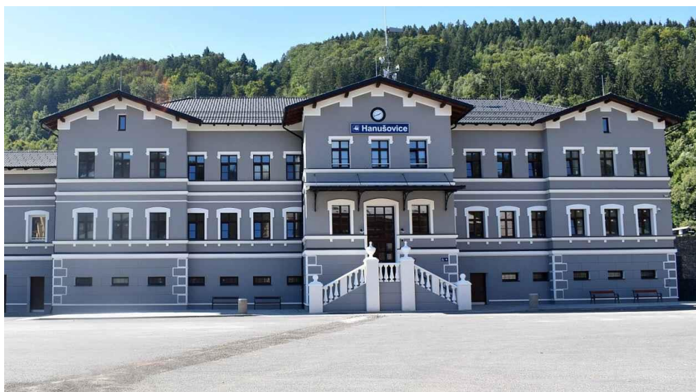
Obrázek 4 Zrekonstruované nádraží v Hanušovicích
