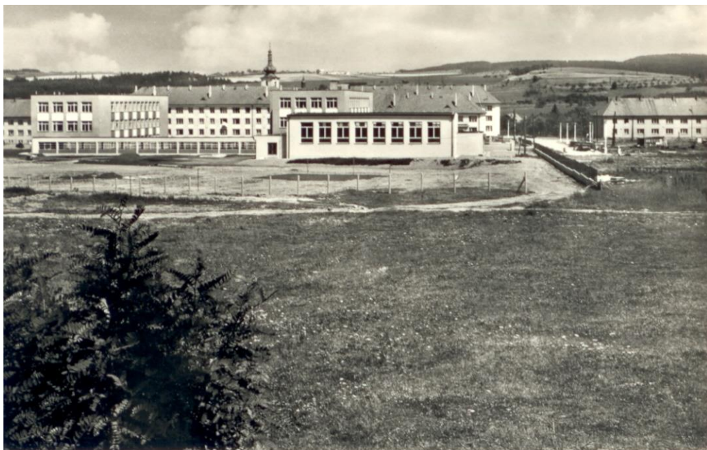
Obrázek 19- fotografie dokumentující výstavbu nové základní školy, v pozadí jsou viditelné nové obytné domy a věž kostela. 119
