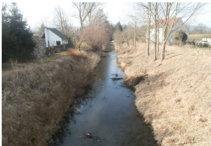
Obr. 48: Pohled na upravené koryto v městyse Katovice (autor)
