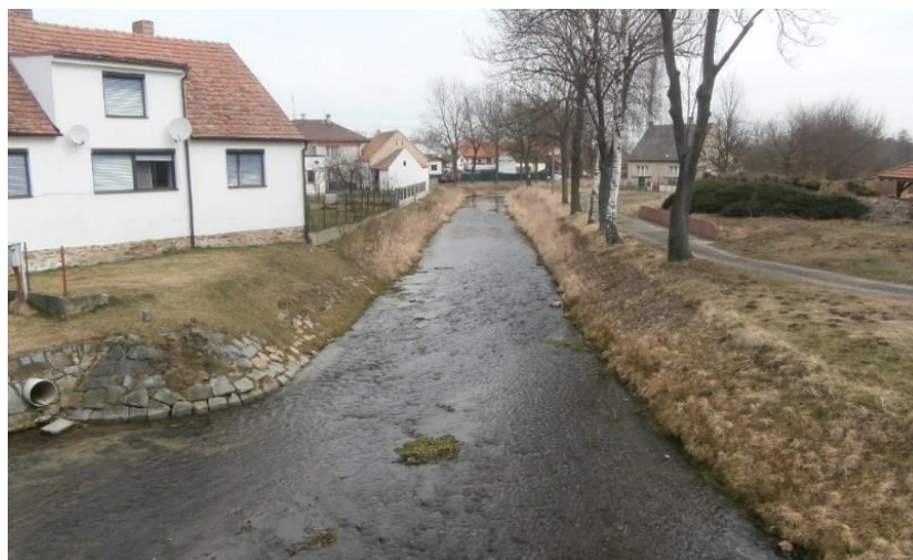
Obr. 45: Pohled na upravené koryto v obci Novosedly (autor)
