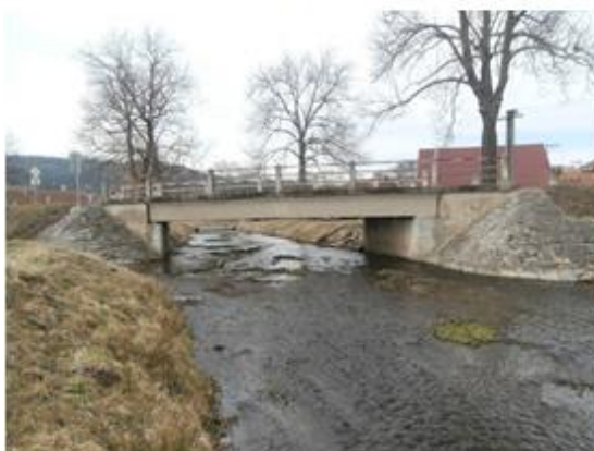
silniční most Novosedly ř.km 3.390
