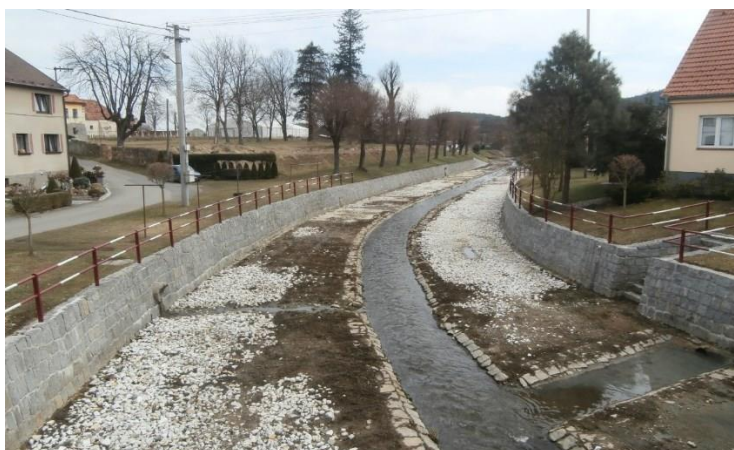
Obr. 42: Pohled na upravené koryto v obci Štěchovice (autor)
