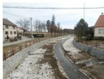
napřímené, kamenný zához, kamenné zdi n = 0.042
