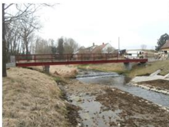
lávka Štěchovice ř.km 6.830
