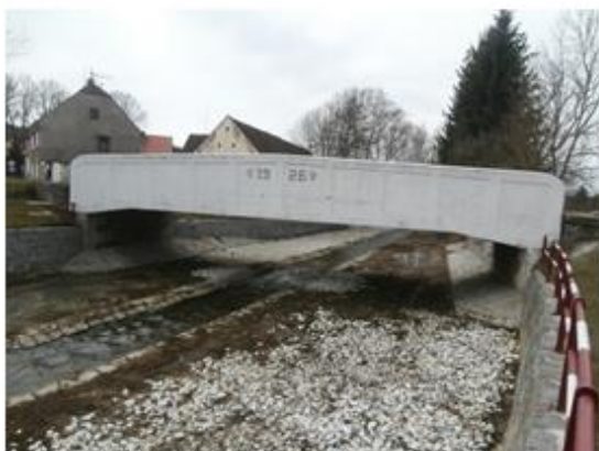
silniční most Štěchovice ř.km 6.461
