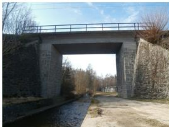
železniční most Katovice ř.km 0.475
