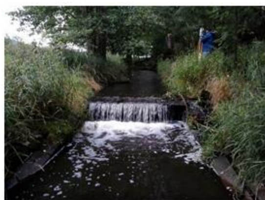
kamenný stupeň Močidla ř.km 1.818
