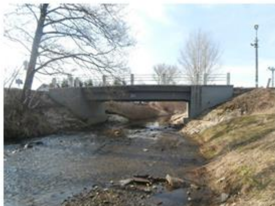
silniční most Katovice ř.km 0.134
