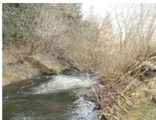
jez Močidla ř.km 1.520
