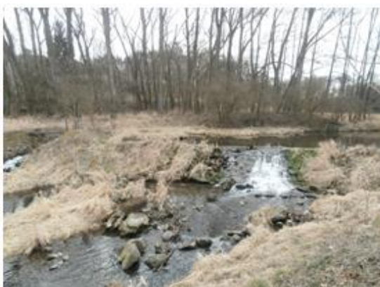
jez Štěchovice ř.km 6.928
