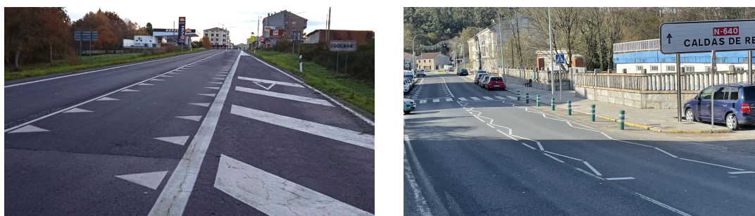
Obrázek 4.1: Instalovaná dopravní opatření v obcích Agolada a Cuntis. Vlevo: dračí zuby. Vpravo: klikaté čáry. Zdroj: CDV.
