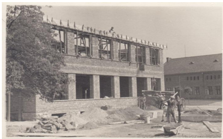
Obrázek 2 Stavba nové školní budovy v roce 1937
