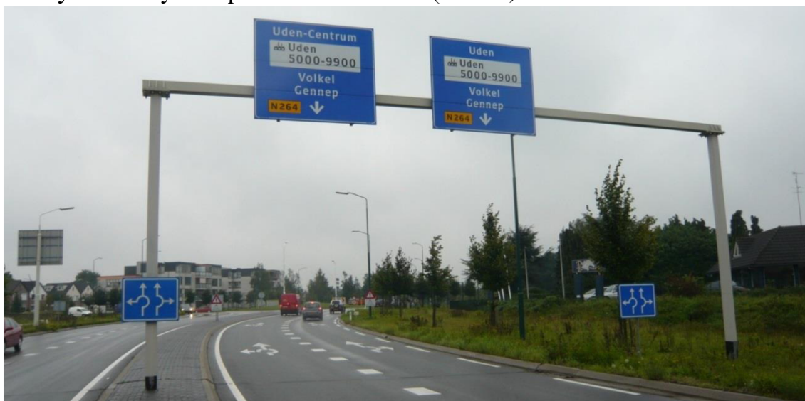
Obr. 2 Svislé a vodorovné dopravní značka před okružní křižovatkou se spirálovitým uspořádáním (TOK – Holandsko – město Uden)
