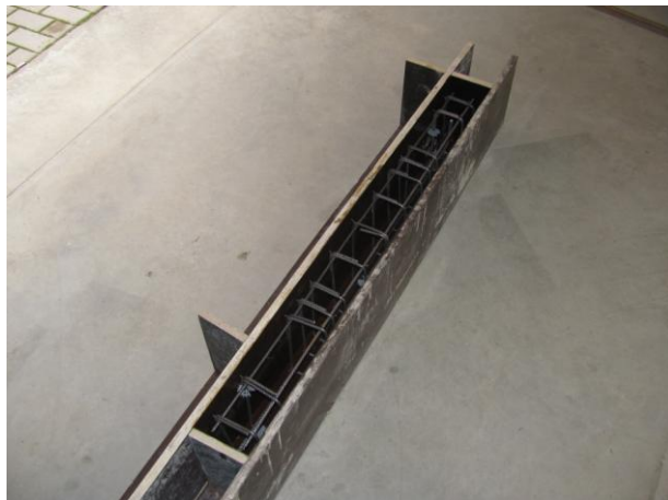
Obr. 1.5. Bednění s armokošem
