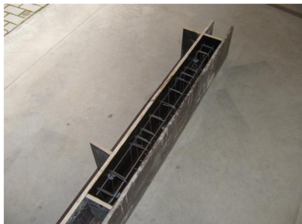
Obr. 1.5. Bednění s armokošem
