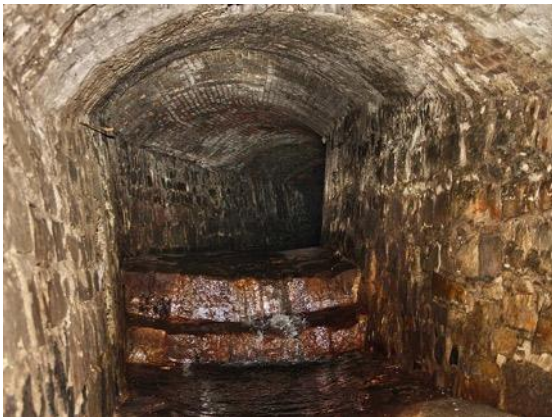
37 Kaskádovité stupně v tunelu Pokratického potoka (Zdroj: http://spravnym.smerem.cz )
