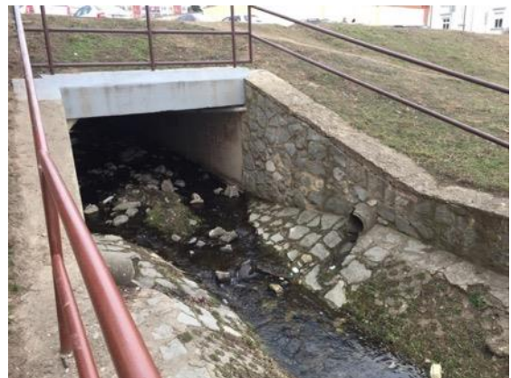
28 Přemostění v ulici Březinova cesta, pohled zespod (Foto: Simon, 3/2019)
