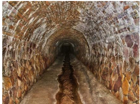
38 Spodní část tunelu vystavěná z kamene a cihel (Zdroj: http://spravnym.smerem.cz )
