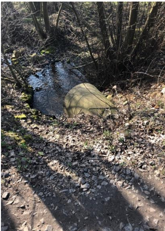
15 Propustka pod pozemní komunikací nad Bývalým Lbínským mlýnem (Foto: Simon, 3/2019)
