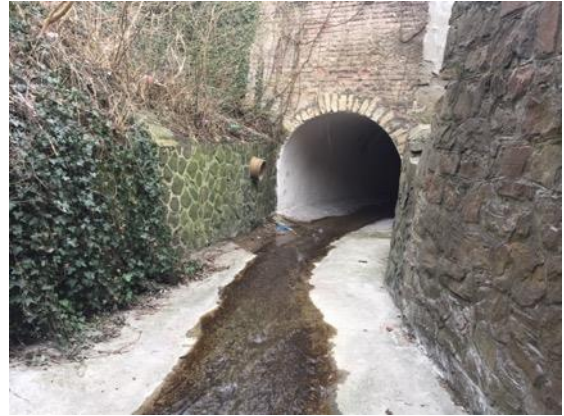
36 Přerušení tunelu Pokratického potoka 2/2 (Foto: Simon, 3/2019)
