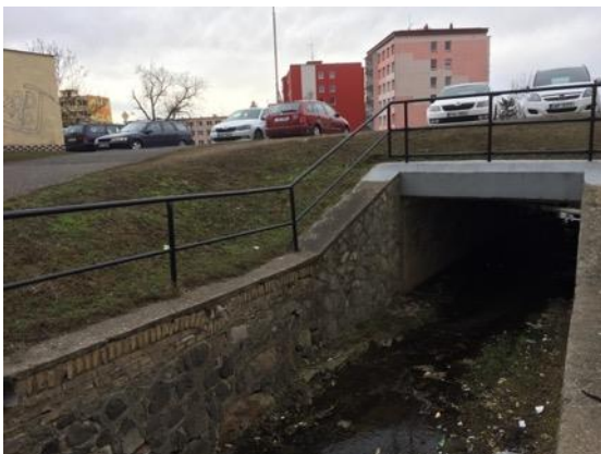
27 Přemostění v ulici Březinova cesta, pohled shora (Foto: Simon, 3/2019)
