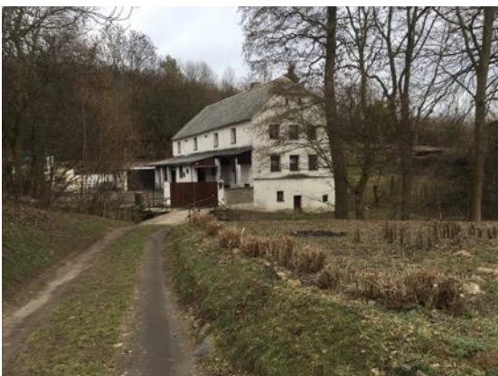
05 Současný stav Štampová mlýna (Foto: Simon, 3/2019)
