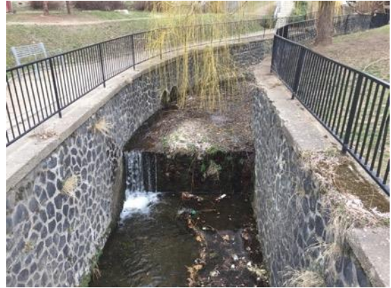
24 Spádový stupeň ve zděném korytu Pokratického potoka (Foto: Simon, 3/2019)
