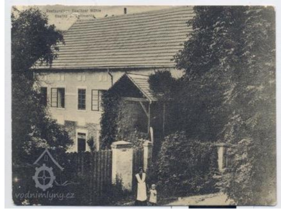
02 Restaurace Skalický mlýn, přelom 18. a 19. století (Zdroj: http://vodnimlyny.cz )
