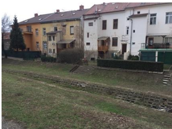
09 Řadové domky v místě bývalého Mlýnu v Pokraticích IV (Foto: Simon, 3/2019)
