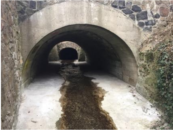
35 Přerušení tunelu Pokratického potoka 1/2 (Foto: Simon, 3/2019)
