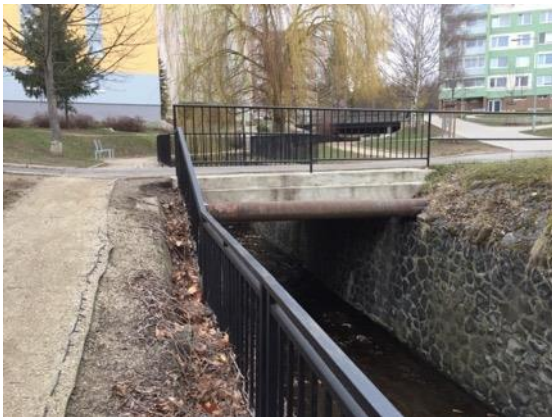
25 Lávka přes Pokratický potok, v pozadí zrekonstruovaná lávka (Foto: Simon, 3/2019)
