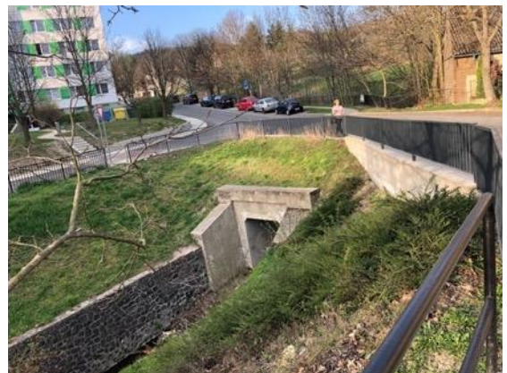
22 Propustka pod komunikací na sídlišti v Pokraticích (Foto: Simon 3/2019)
