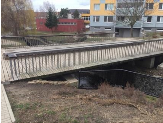
23 Zrekonstruovaná lávka přes Pokratický potok v místě, kde je veden zděným korytem (Foto: Simon, 3/2019)
