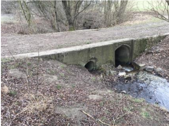
19 Propustka pod příjezdovou cestou k Pokratickému rybníku (Foto: Simon, 3/2019)
