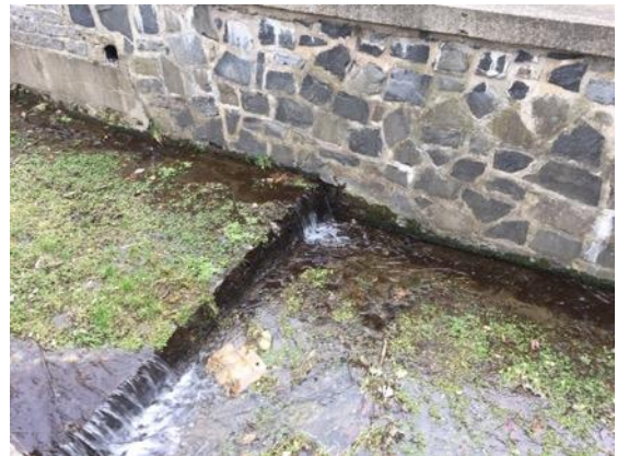
26 Spádový stupeň ve zděném korytu Pokratického potoka (Foto: Simon, 3/2019)
