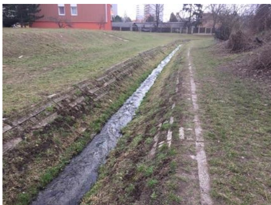
29 Zpevněné koryto pomocí opevňovacích tvárnic (Foto: Simon, 3/2019)
