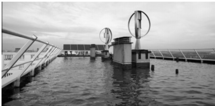
Obrázek 36 Horní nádrž PHES umístěná na střeše budovy společně s PV a WP [19]
