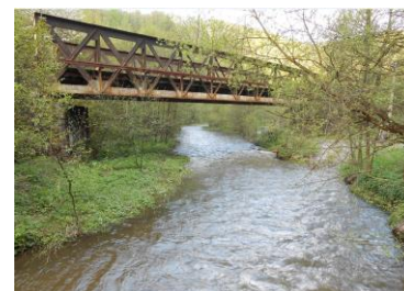
Obr. 131: Vodní energie se využívala k pohonu mlýnů
