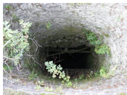
Obr. 7: Podpovrchová těžba břidlice – lom Velká Střelná
