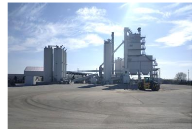
Obr. 125: Výrobní asfaltových hmot ve Velké Bystřici
