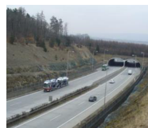
Obr. 142 Ekokodukt u Dolního Újezdu slouží zvířatům k průchodu mezi Oderskými vrchy a Moravskou bránou.
