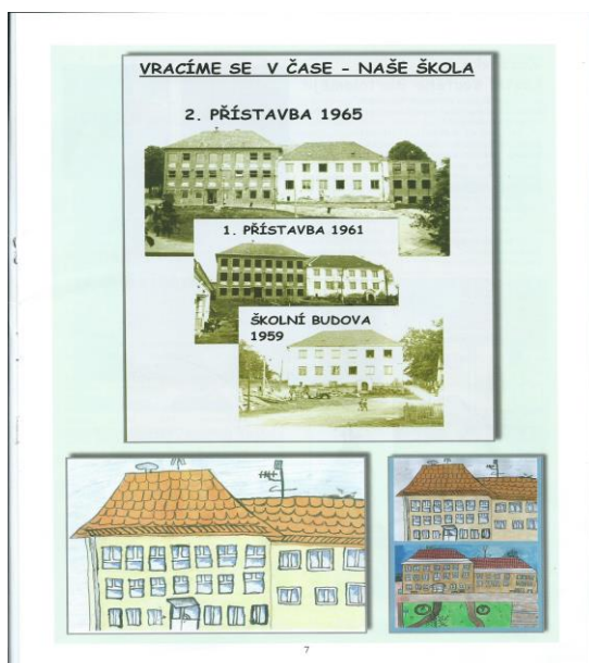
Obr. 17. přístavby (archiv Školní virtuálně
