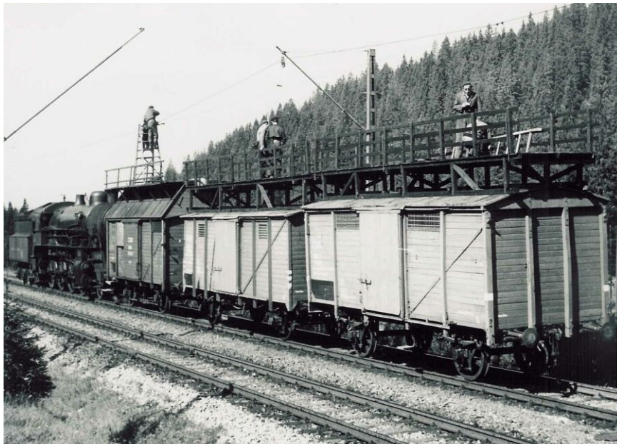
Obr. 2.2 Pracovní vlak Elektrizace železnic Praha
