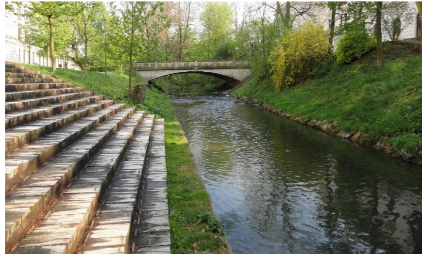
Obr. 13 Pobytové schodiště v blízkosti sídliště. (autorka, 2015)
