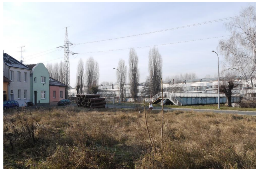
Obr. 60 Současný stav – provizorní lávka připevněna na potrubí. (autorka, 2016)
