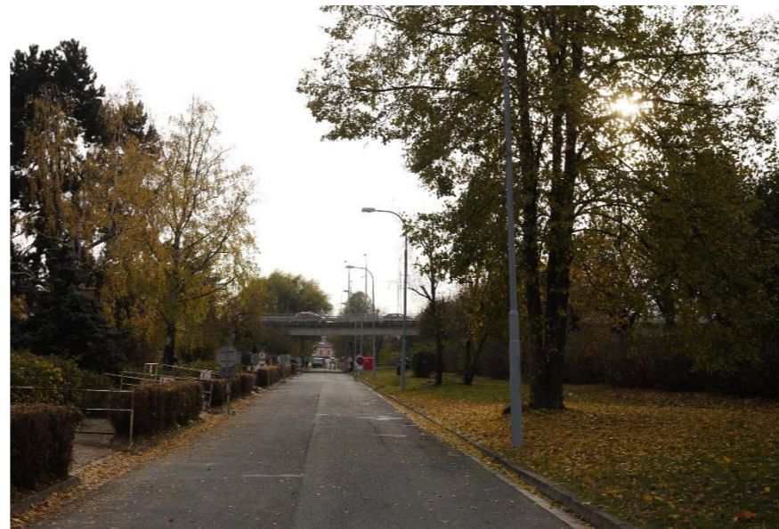
Obr. 75 Současný stav – přímý pohled pod most. (autorka, 2016)
