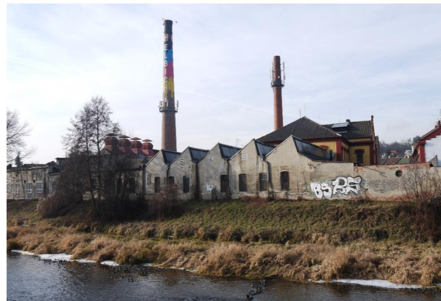
Obr. 82 Výhled na objekt Mosilany. (autorka, 2016)
