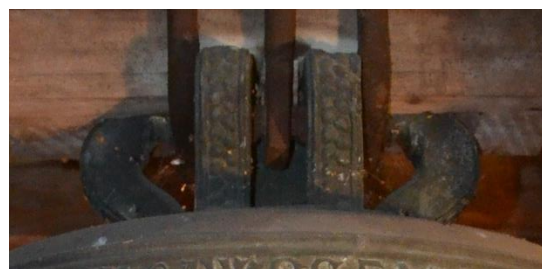
76 – detail koruny zvonu z Korouhve
