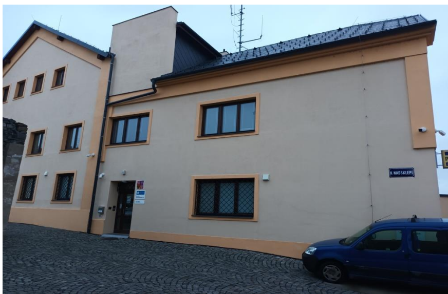
Obrázek č. 5 Budova obvodního oddělení Policie České republiky Lipník nad Bečvou ( zdroj: vlastní )
