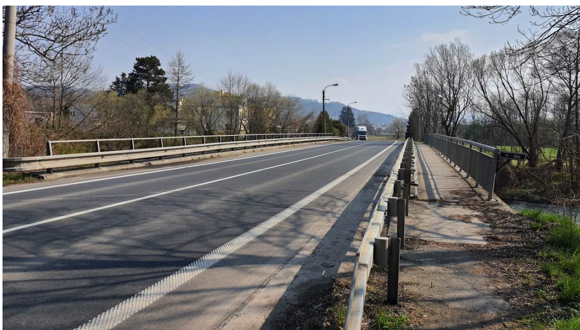
Obr. 22 – Silnice I/11 mezi obcemi Chromeč a Bludov v roce 2021; zdroj: vlastní fotografie
