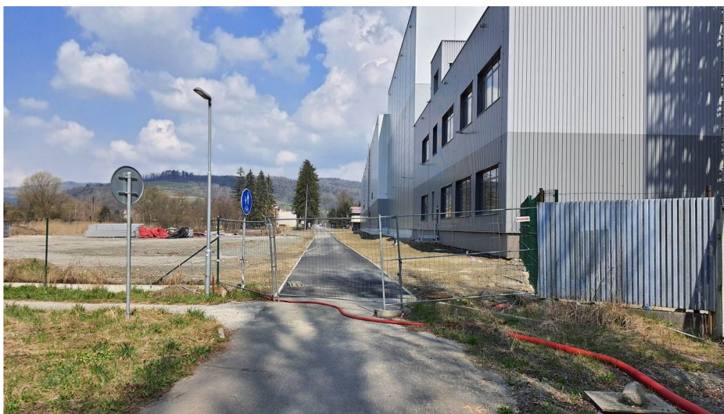
Obr. 19 – Komunikace, po které povede nový úsek Moravské stezky mezi Olšany a Kláštercem v roce 2021; zdroj: vlastní fotografie
