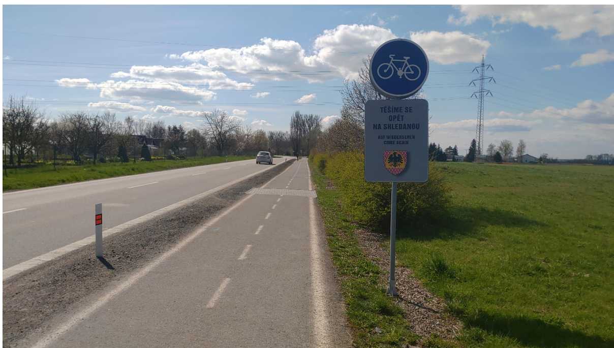
Obr. 9 – Příklad extravilánu v Uničově v roce 2021; zdroj: vlastní fotografie
