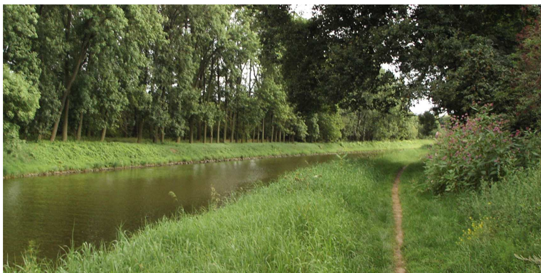
Obr. 63: Vraňansko-hořínský plavební kanál. (Foto: autor)
