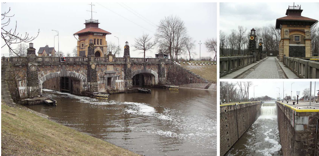
Obr. 16, 17, 18: Vraňansko-hořínský plavební kanál se zdymadly. (Foto: autor)
