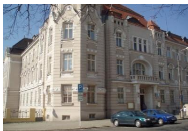
Obr. č. 4 - Budova OŘ PČR Litoměřice
