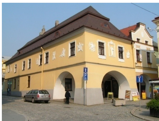
Obr. č. 6 – dům U apoštolů
