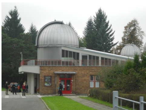
Obr. č. 14 – Hvězdárna
