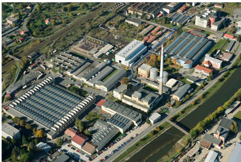
Obr. 3.1: Společnost TES Vsetín s.r.o. [23]
