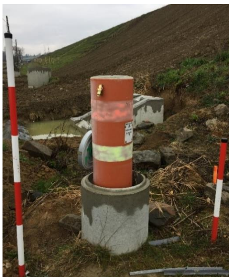
Obrázek 17 – Těžká stabilizace bodu č. 6032 [autor]
