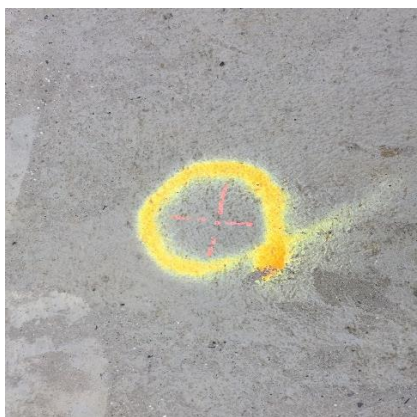
Obrázek 3 – Signalizace bodu na mostní konstrukci [autor]
