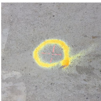
Obrázek 3 – Signalizace bodu na mostní konstrukci [autor]
