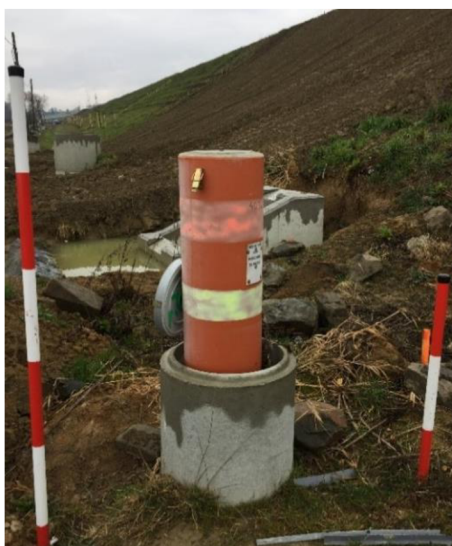
Obrázek 17 – Těžká stabilizace bodu č. 6032 [autor]
