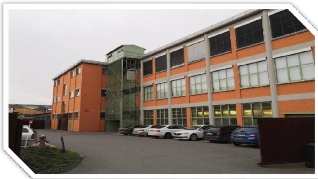
Obr. 9: Pohled na zrekonstruované sídlo společnosti (budova č. 74) (Zdroj: Pařenica, 2021)
