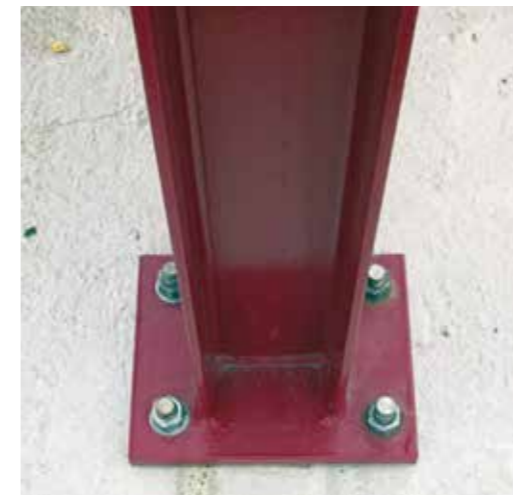
Obr. 45: Kotvení šroubů (zdroj: ampekotech.cz)
