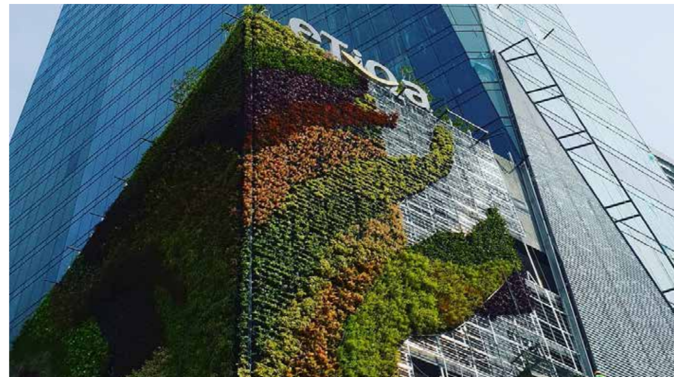
Obr. 16: VERITAS Landscape Sdn Bhd (zdroj: Greenroofs 2018)
